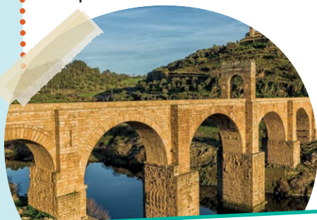
El Puente de Alcántara, en Cáceres, está muy bien conservado.
